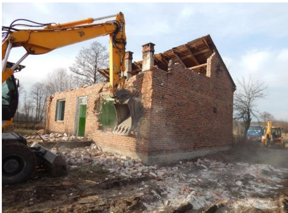
Zdjęcie 6 Przykład rozbioru budynku mieszkalnego w Górkach
